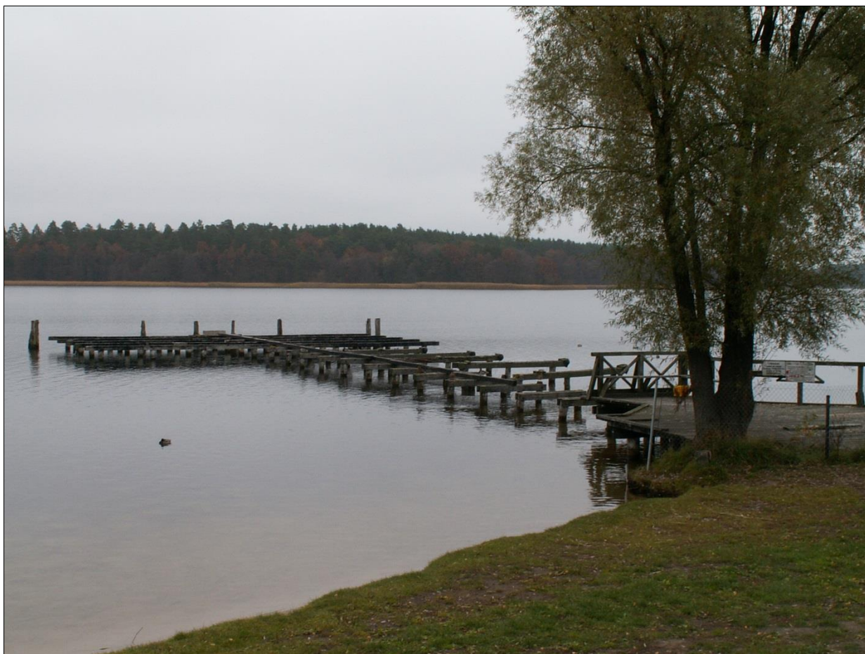
Widok pomostu od strony lądu.
