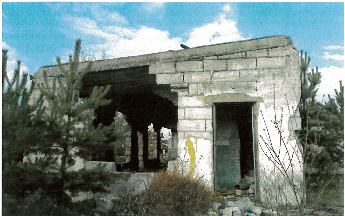
Fot. 4: Widok budynku od strony południowo-zachodniej
